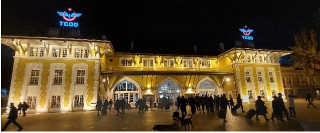
Şekil 31. Adana İstasyonu giriş cephesi (Yazar)
