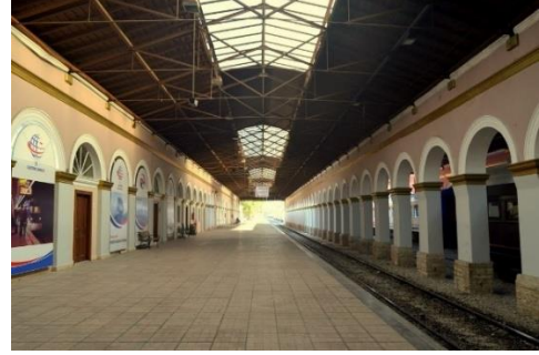
Şekil 2. Alsancak Tren İstasyonu peron görünümü (Visit İzmir, t.y.)
