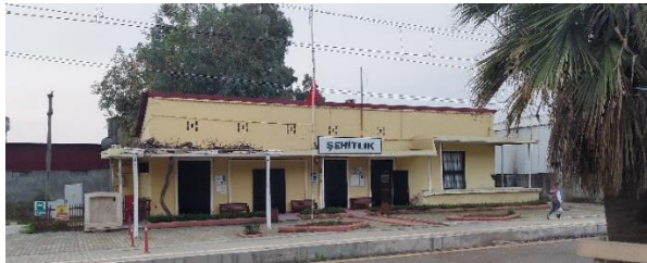
Şekil 30. Şehitlik İstasyonu peron cephesi (Yazar)
