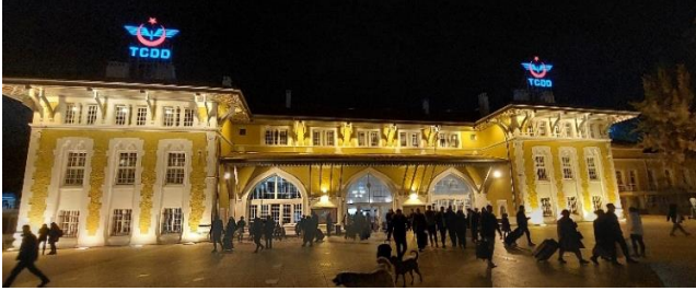
Şekil 31. Adana İstasyonu giriş cephesi (Yazar)
