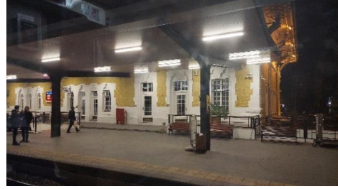
Şekil 32. Adana İstasyonu peron cephesi (Yazar)
