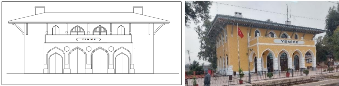
Şekil 29. Yenice İstasyonu peron cephesi (Yazar)
