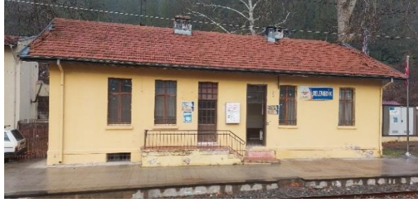
Şekil 25. Belemelik İstasyonu peron cephesi (Yazar)
