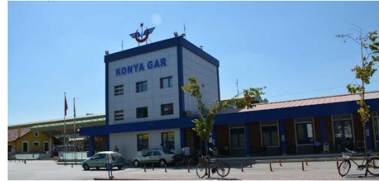
Şekil 12. Kullanımdaki Konya Tren İstasyonu giriş cephesi (TCDD, 2021)
