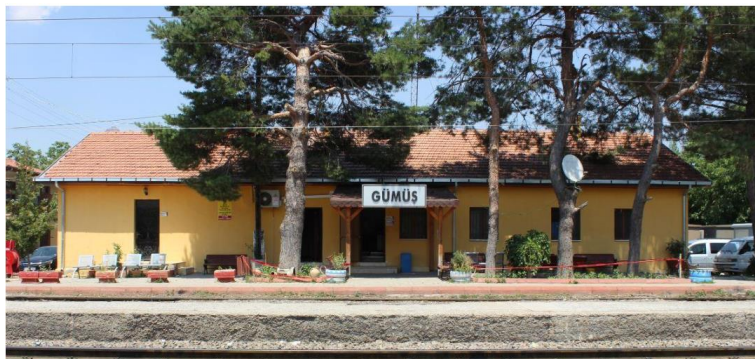
Şekil 21. Gümüş Tren İstasyonu (Arar, 2020, s. 202)
