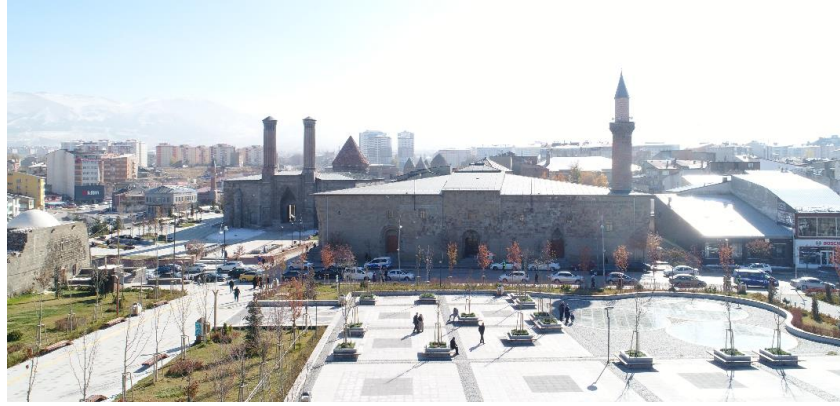
Şekil 18. Ulu Cami Giriş (Kuzey) Cephesi (Vakıflar Bölge Müdürlüğü Arşivi, 2023)
