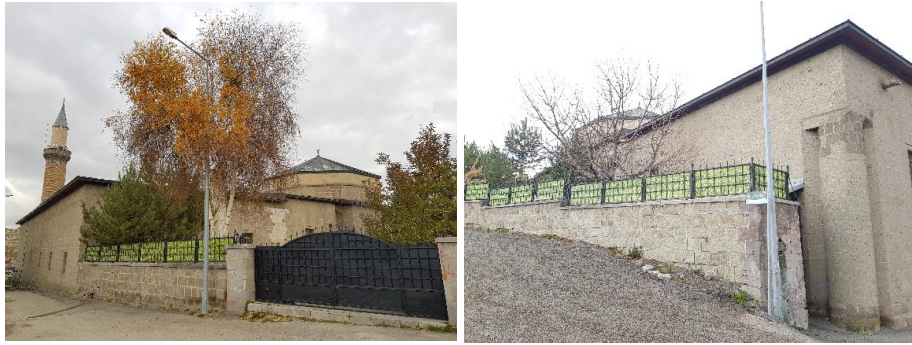
Şekil 21. Ulu Cami Güney Cephesi
