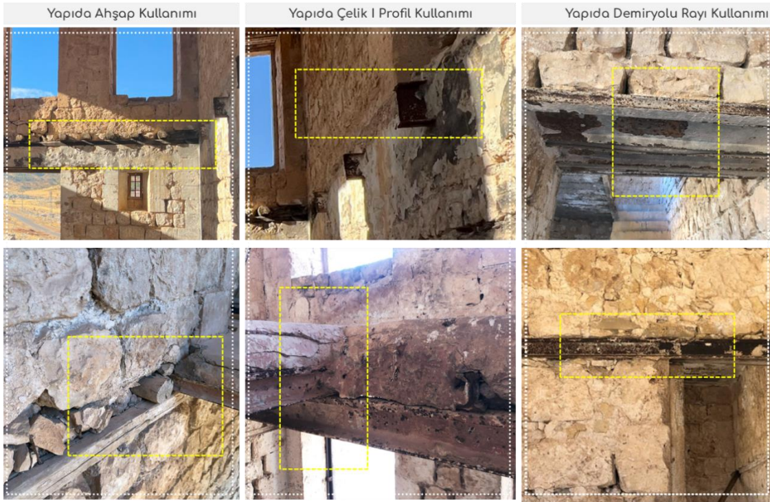
Şekil 6. Yapıda Ahşap, Çelik I Profil ve Demiryolu Rayı Kullanımı (Yazarlar tarafından üretilmiştir.)
