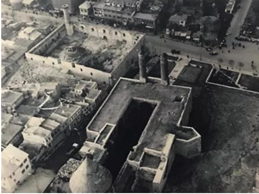
Şekil 11. Yapının Depremde Yıkılmış Hâline Ait Üstten Bir Fotoğraf (Vakıflar Bölge Müdürlüğü Arşivi, 2023)
