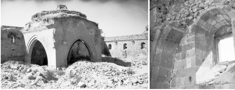
Şekil 10. Depremde Yıkılan Yapının Kubbe ve Kemerine Dair Fotoğraflar (Salt Araştırma Fotoğraf Arşivi, 2023)
