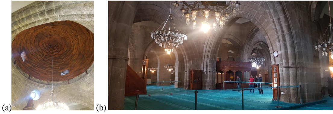
Şekil 26. (a) Mihrap Önü Ahşap Kırlangıç Örtü (5 No.lu Bakış), (b) Mihrap Önü (6 No.lu Bakış)
