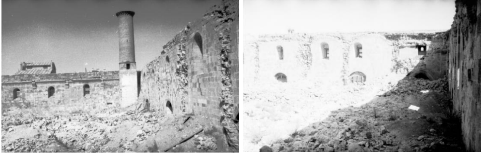
Şekil 9. Yapının İçinden Depremde Yıkılmış Hâline Ait Fotoğraflar (Salt Araştırma Fotoğraf Arşivi, 2023)
