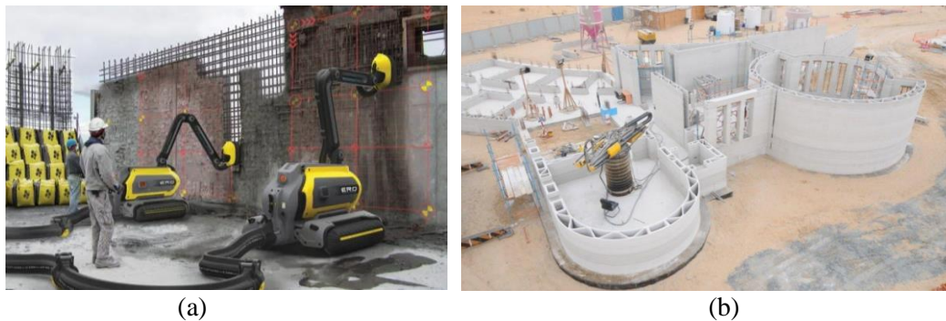
Şekil 3. (a) Tek Kollu Saha Robotları (Anyango, 2022), (B) Sahada Üç Boyutlu Yazıcı ile Katmanlı Üretim Uygulaması (Zeiba, 2019)
