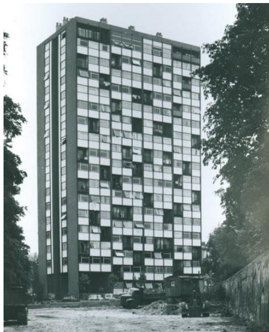
Figure 6. La Tour Bois-le-Prêtre in 1960s (Lacaton & Vassal, 2011)
