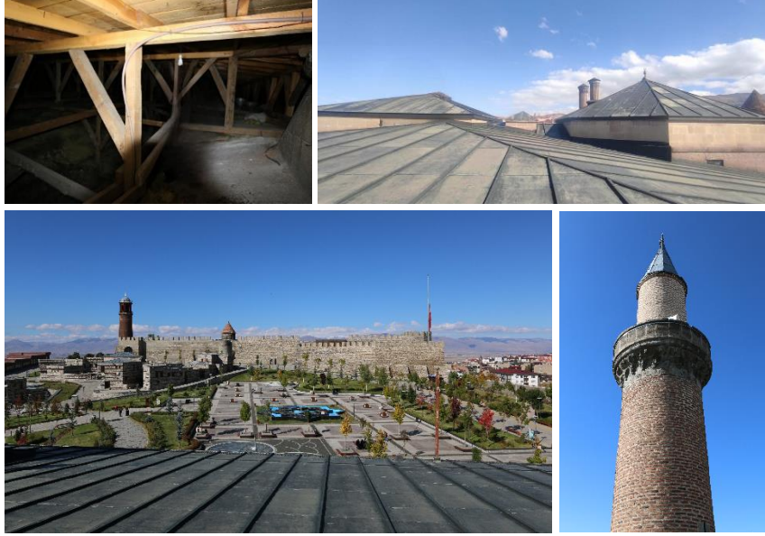
Şekil 28. Çatı ve Minareye Ait Fotoğraflar
