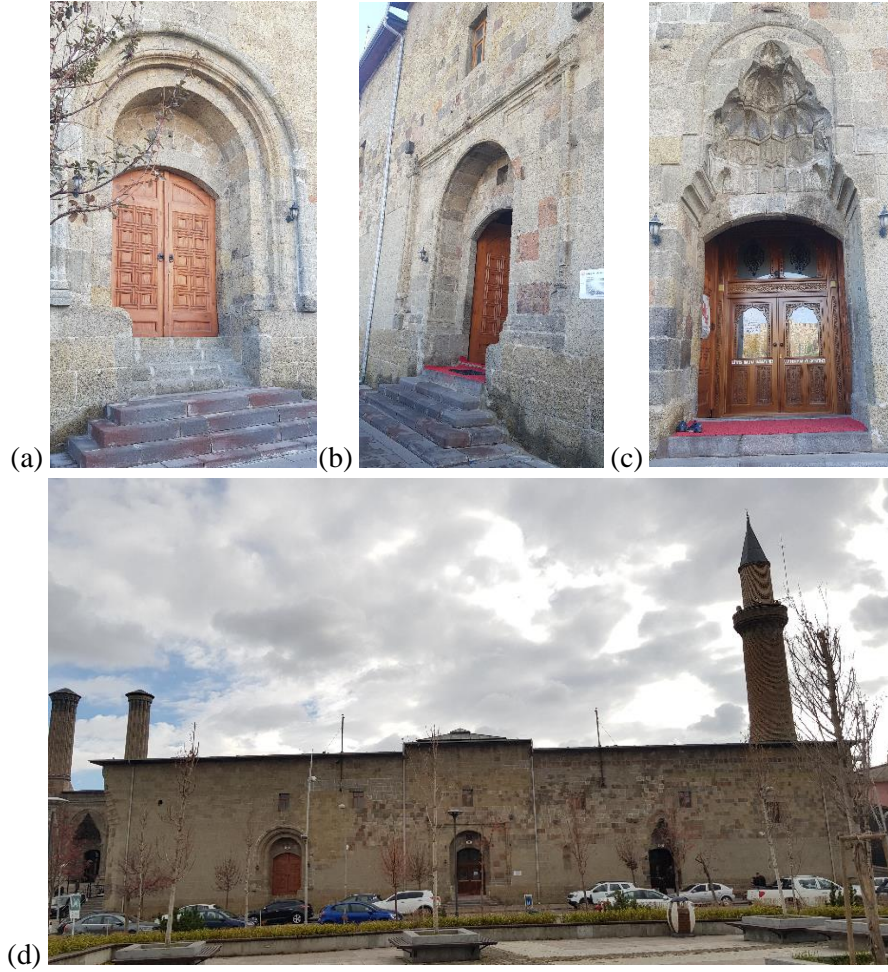
Şekil 19. (a) Kuzey Cephesi Doğu Girişi, (b) Kuzey Cephesi Ana Giriş, (c) Kuzey Cephesi Batı Girişi, (d) Ulu Cami Kuzey (Giriş) Cephesi
