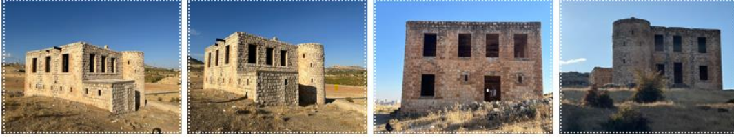
Şekil 2. İzzetpaşa Karakolu Binasına Ait Güncel Durum (Yazarlar arşivi, 2024)
