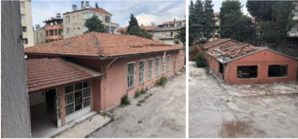
Şekil 11. Yapının muhdes bağlantısı ve bahçeye sonradan yapılan niteliksiz yapı
