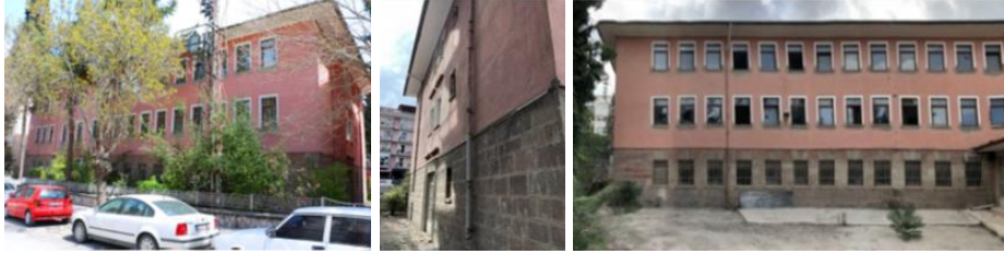
Şekil 5. Yapının cephe fotoğrafları
