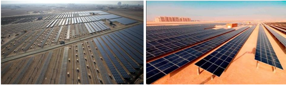
Şekil 9. Masdar Şehri Fotovoltaik Çiftliği (URL-7, URL-8)
