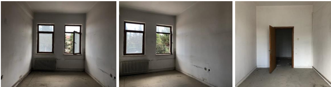
Şekil 17. İkinci Kat-215-Derslik mekanına ait süpürgelikler
