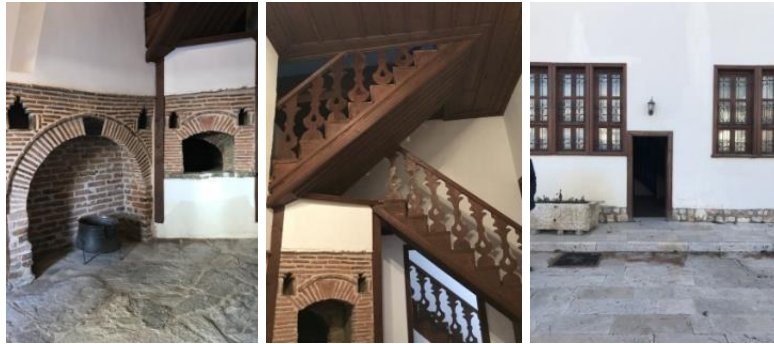
Şekil 28. Gazi Osman Paşa Konağı İşevi-Ocak-Merdiven ve Bahçe Kapısı Görünümü (Talu, 2018)
