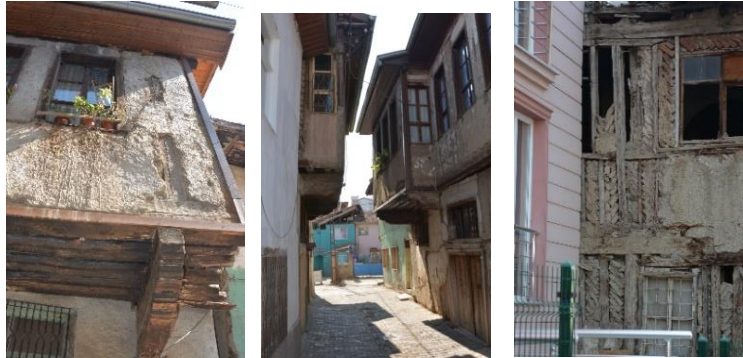
Şekil 2. Tokat Geleneksel Konut Mimarisi yapım sisteminden Örnekler (Uzun T.arşivi, 2014)
