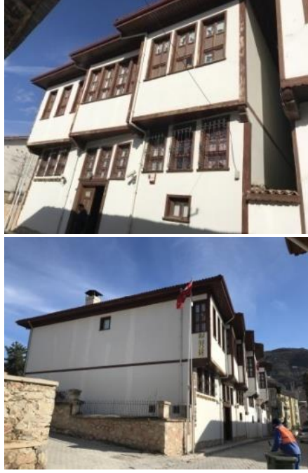
Şekil 36. Gazi Osman Paşa Konağı 2018 Yılı Ön Cephe Görünümü (Talu, 2018)
