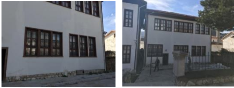
Şekil 24. Gazi Osman Paşa Konağı Arka Cephe Görünümü (Talu, 2018)
