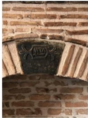
Şekil 23. Gazi Osman Paşa Konağı Ocak Üzerindeki Orijinal Taşa Yazılı Yapım Yılı (Talu, 2018)
