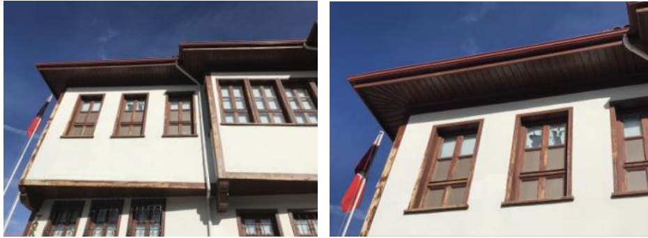
Şekil 37. Gazi Osman Paşa Konağı Çatı Saçağı Görünümü (Talu, 2018)
