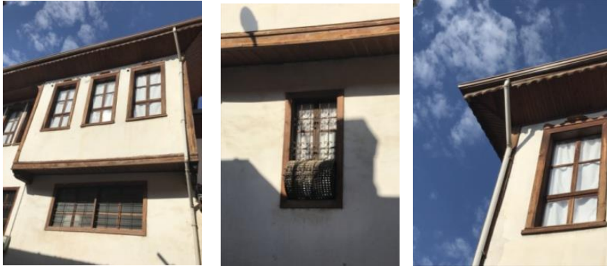
Şekil 45. Cevdet Erek Konutu Ön Cephe Pencereleri ve Çatı Saçağı (Talu, 2018)
