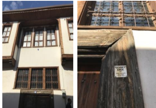
Şekil 41. Cevdet Ereğ Konutu İki Kanatlı Ahşap Kapı Görünümü (Talu, 2018)
