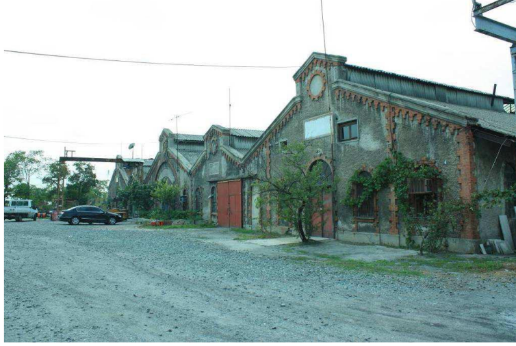
Şekil 3. Güneydoğu cephesi görünüşü (Erdoğan, 2012)
