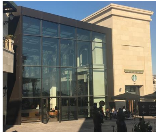
Şekil 26. Geniş koridoru örten çağdaş örtü sistemi/kabuk (Aşan, R.)
