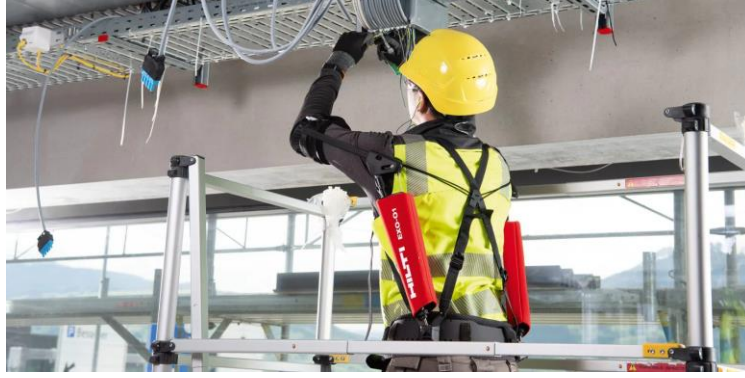
Şekil 5. İnşaat Alanında Giyilebilir Robotların Kullanımı (Hilti, 2022)
