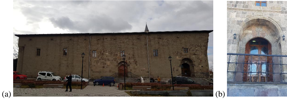
Şekil 20. (a) Ulu Cami Doğu (Kadınlar Girişi) Cephesi, (b) Doğu Cephesi Batı Girişi
