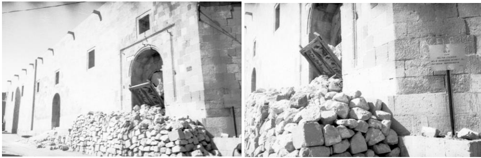
Şekil 8. Kuzey Cephesinden Yapının Depremde Yıkılmış Hâline Ait Fotoğraflar (Salt Araştırma Fotoğraf Arşivi, 2023)
