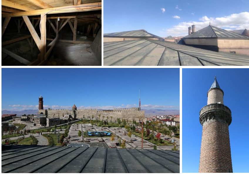
Şekil 28. Çatı ve Minareye Ait Fotoğraflar
