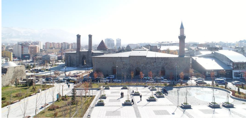
Şekil 18. Ulu Cami Giriş (Kuzey) Cephesi (Vakıflar Bölge Müdürlüğü Arşivi, 2023)
