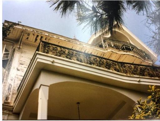
Şekil 10. Köşkün birinci kat balkonu (V No'lu Kültür Varlıklarını Koruma Bölge Kurulu arşivi, 2020)
