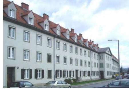
Şekil 15. Dieselweg 3-19 cephe fotoğrafı (Zimmermann, 2011)
