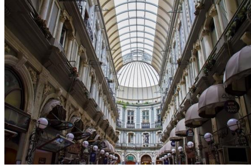
Şekil 31. Çiçek Pasajı örtü sistemi (Url-9)
