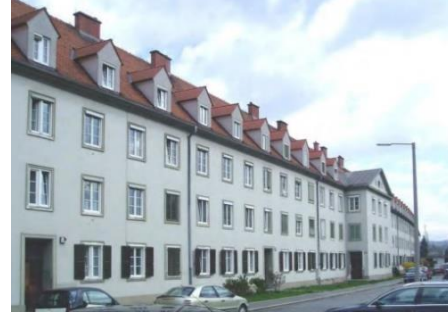
Şekil 15. Dieselweg 3-19 cephe fotoğrafı (Zimmermann, 2011)
