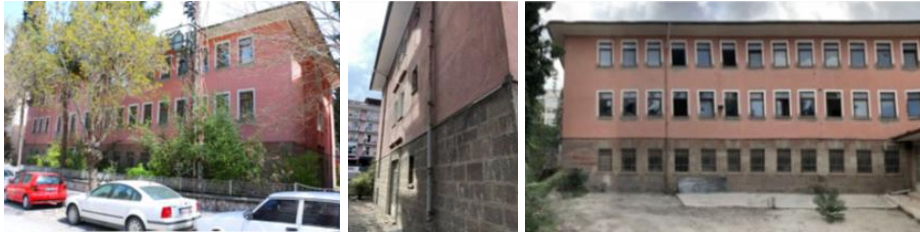
Şekil 5. Yapının cephe fotoğrafları
