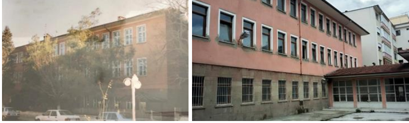
Şekil 23. Cephedeki denizliklerin özgün ve günümüzdeki hali (Burdur İl Milli Eğitim Müdürlüğü Arşivi)
